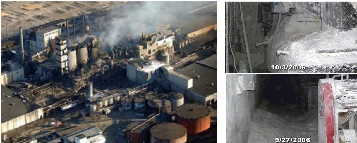
Fig. 1. Explosión en las instalaciones de Imperial Sugar Company en 2008, Port Wentworth refinery, Georgia (fuente: https://sma.nasa.gov/news/safety-messages/safety-message-item/dust-to-dust )
