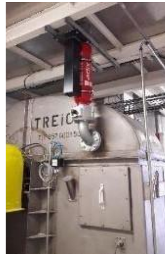
Figura 3 Paneles de venteo en elevador Figura 4. Sistema de supresión química en elevador
