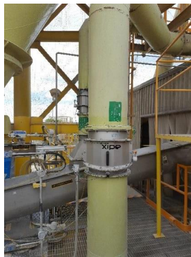
Figura 6. Sistemas de protección contra explosiones (válvulas de clapeta) en filtros de mangas (fuente: ADIX)
