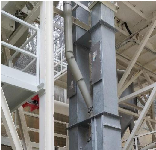
Figura 3 Paneles de venteo en elevador Figura 4. Sistema de supresión química en elevador
